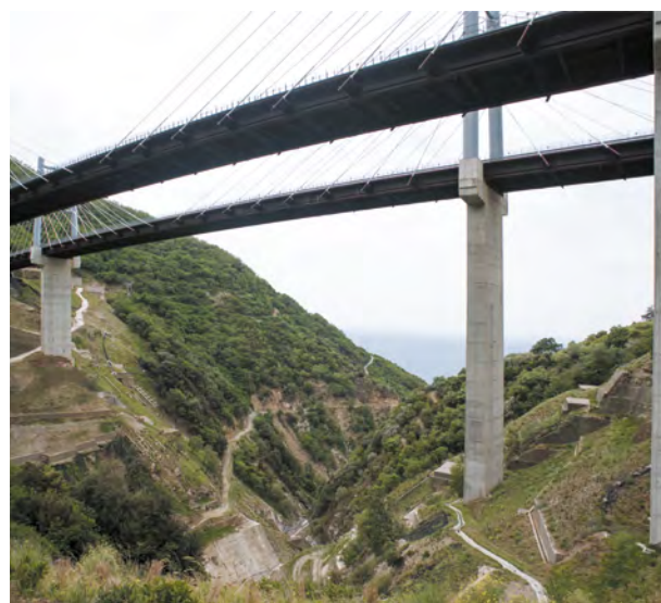
A2 - Autostrada del Mediterraneo - Viadotto Favazzina
