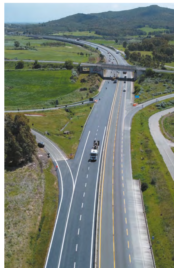
Realizzazione della nuova pavimentazione drenante sulla strada statale 131 - Carlo Felice -
